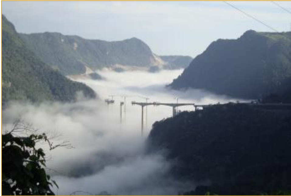
San Marcos Viaduct Itzatlán (Mexico)
