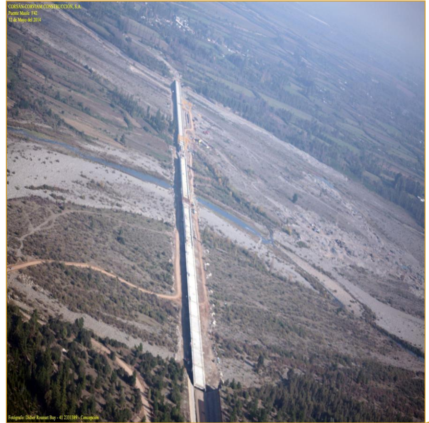
Puente Maule (Chile)
