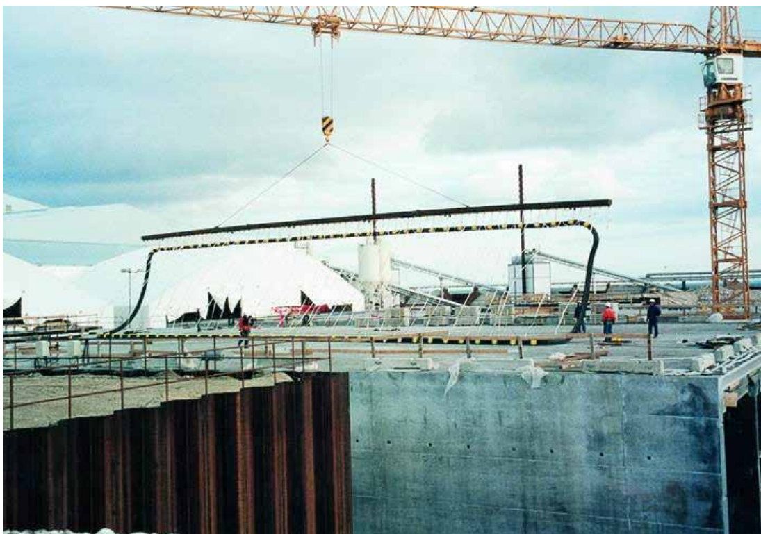
Gina 框架的吊装 (厄勒海峡隧道)
