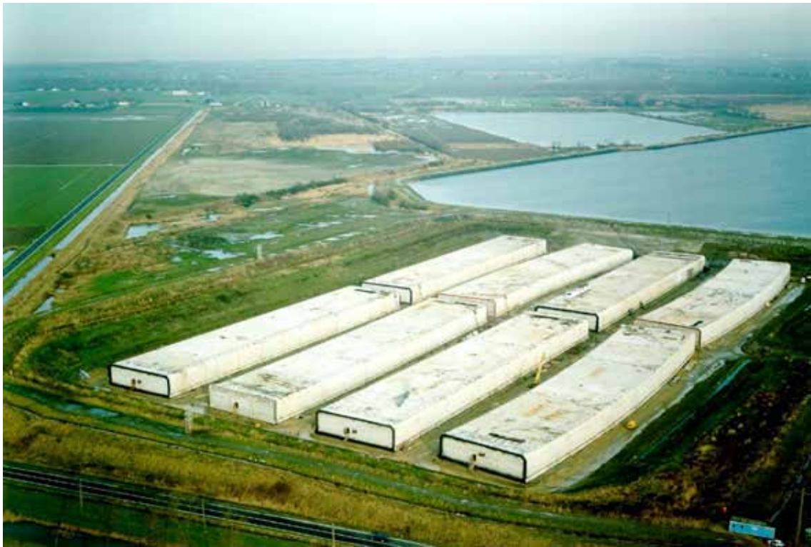
隧道管节预制件工场 — Piet Hein 隧道
