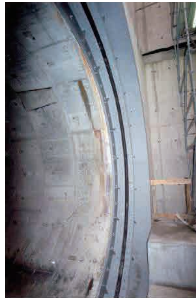
图3与图4：Omega密封件在钻挖隧道中的应用。
