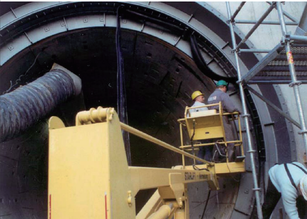
在钻挖隧道和火车站之间安装Omega密封件。
